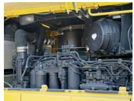
Estación de servicio centralizada
